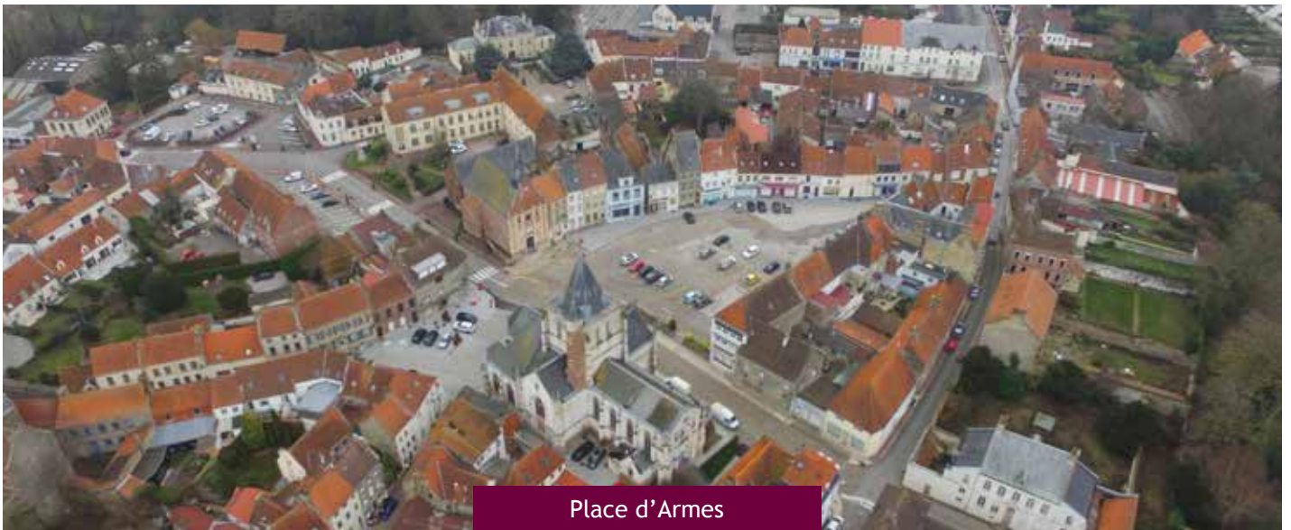
La place d'Armes avant travaux
